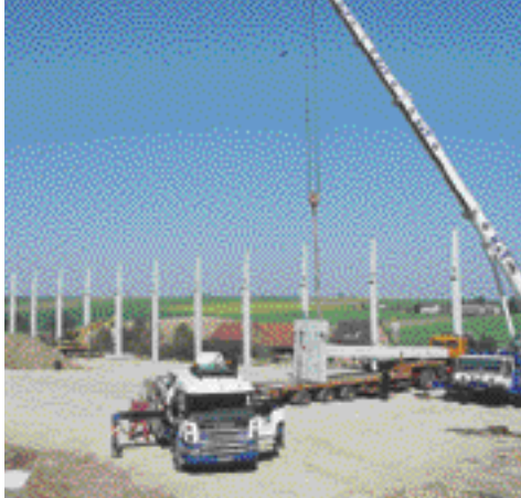
Meilenstein: Neubau einer Fertigungshalle mit neuer Schäumenanlage.
