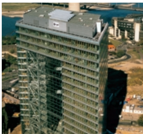
Das Stadttor in Düsseldorf - eines von vielen renommierten Objekten, die mit Doppelböden von Paroll ausgestattet sind.
